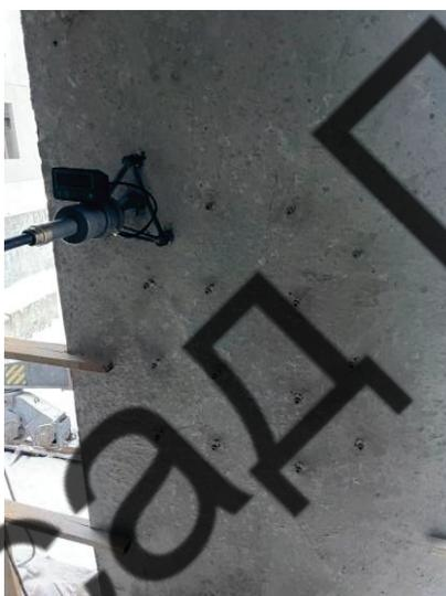
Рис.2 Анкерные дюбели ТМ **ПАРТНЕР** РТ 10x80 MG в железобетонной панели (со слов заказчика).
